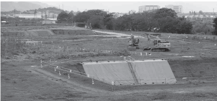
上今井遊水地排水樋門工事
