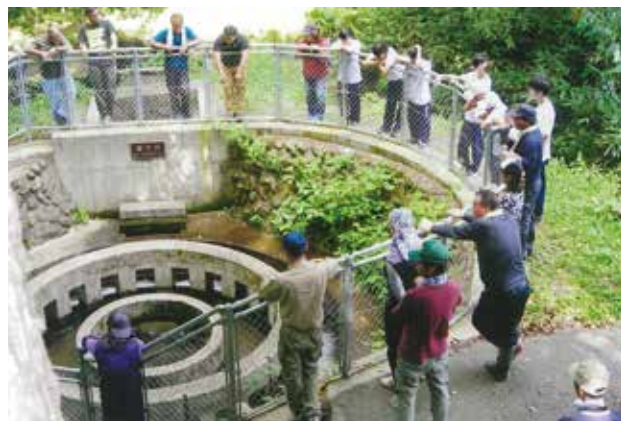
深沢堰分水槽も視察しました
