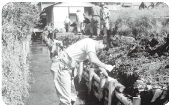
ホタル第3水路の整備
