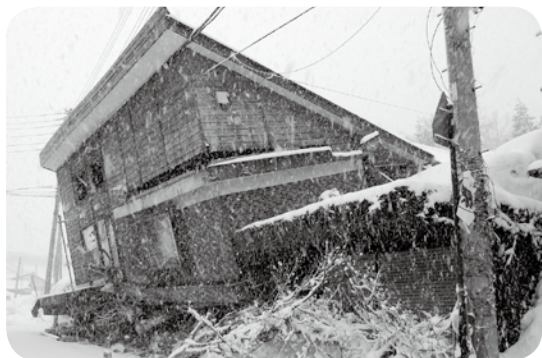
全壊した住宅
