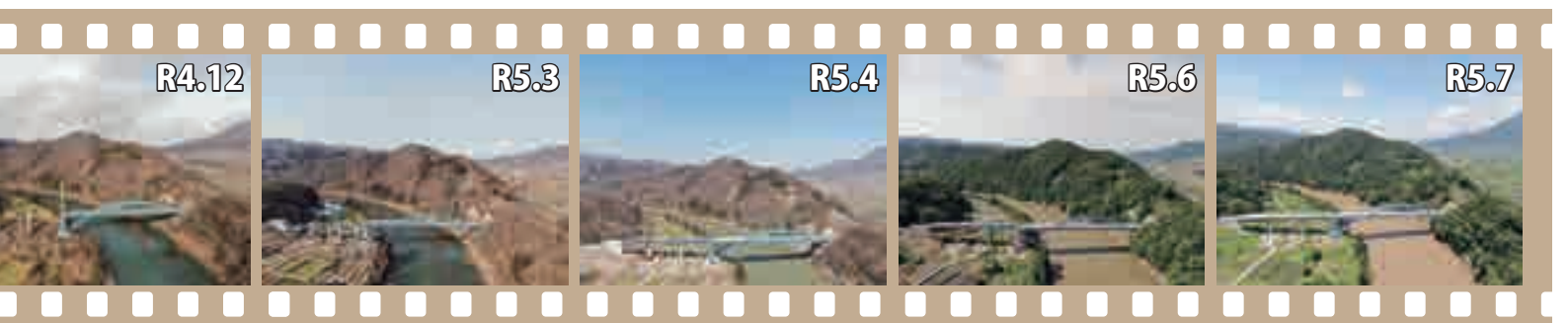
▲7月からアーチの架設が開始。 1部品の設置には1日を要し、約2 カ月で架設が完了。
