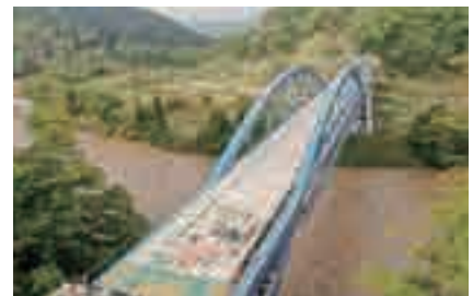
▲補剛桁の架設後、床版を設置し、笠倉壁田橋が完成。開通に向け、道路舗装が開始された。
