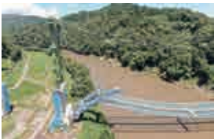
▲7月からアーチの架設が開始。 1部品の設置には1日を要し、約2 カ月で架設が完了。
