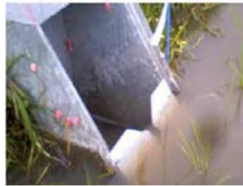
水田排水口の調整装置 設置例
