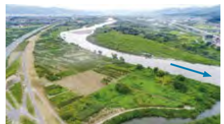
篠井川排水機場から長野市方面
