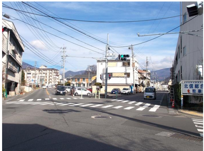
・都市計画道路 3-5-9 立ヶ花東山線、3-5-7 西町上小田中線が交差する吉田交差点周辺(R2年12月現在)
