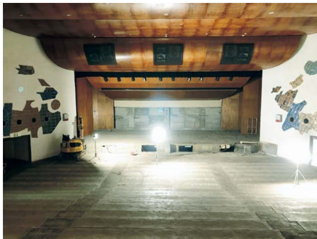
▲客席と舞台床板が解体された大ホール
