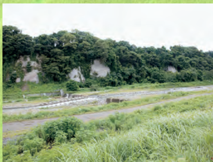
▲十三崖は地質が凝灰岩でつるはしによる素掘りがきき、崩落防止のための支柱の枠組みも不要という好条件だった。
