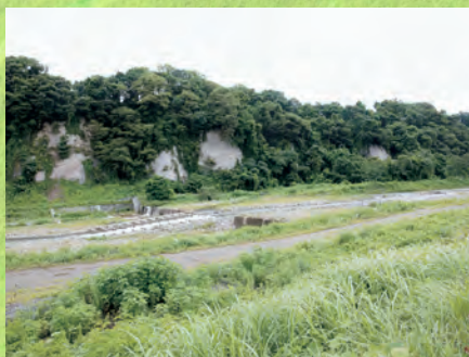
▲十三崖は地質が凝灰岩でつるはしによる素掘りがきき、崩落防止のための支柱の枠組みも不要という好条件だった。
