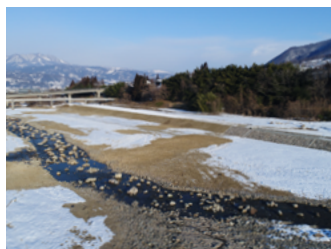
夜間瀬川の現場
