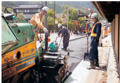
▲土木作業に従事している様子 (写真右側が馬場さん)。
