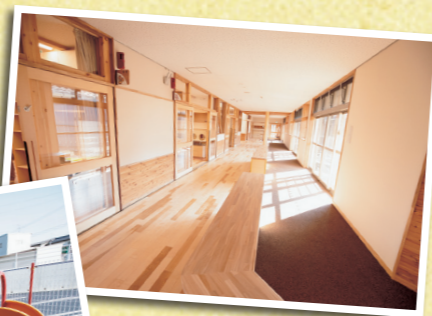
▲ゴムチップを使用し、足場が柔らかい開放的な下足廊下。
