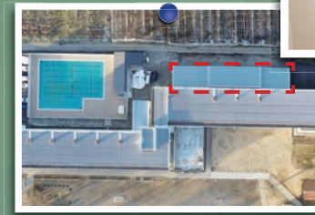
▲北側増築部分（赤い点線箇所）
