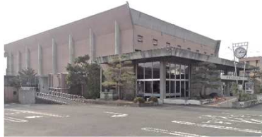
地下1階地上3階建て 延床面積2,157㎡
