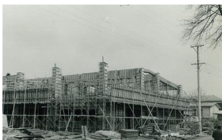
▲現市民会館の建設工事中の様子（昭和 44 年ごろ）
