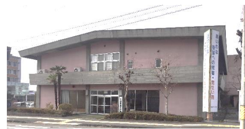
▲市民会館会議室棟
