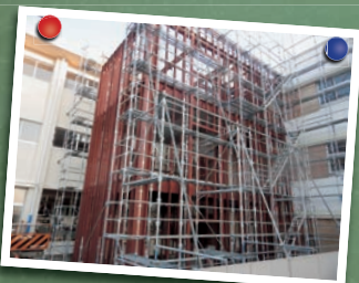
▲エレベーター・トイレ棟の現況
