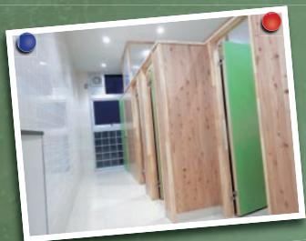
▲改修が完了した3階既存トイレ
