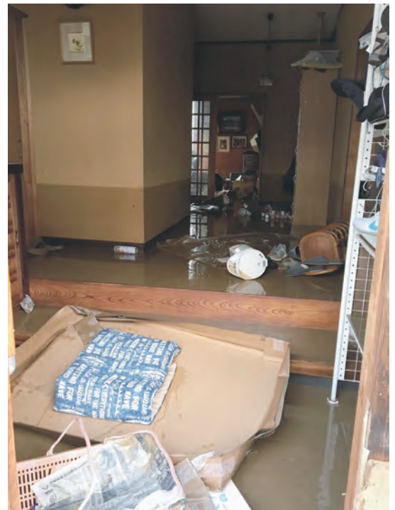
▼床上浸水し、泥まみれになった家屋
