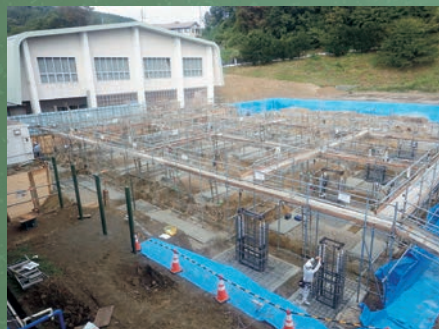
▲新体育館の基礎工事や小学校棟の基礎 掘削工事などが行われています。
