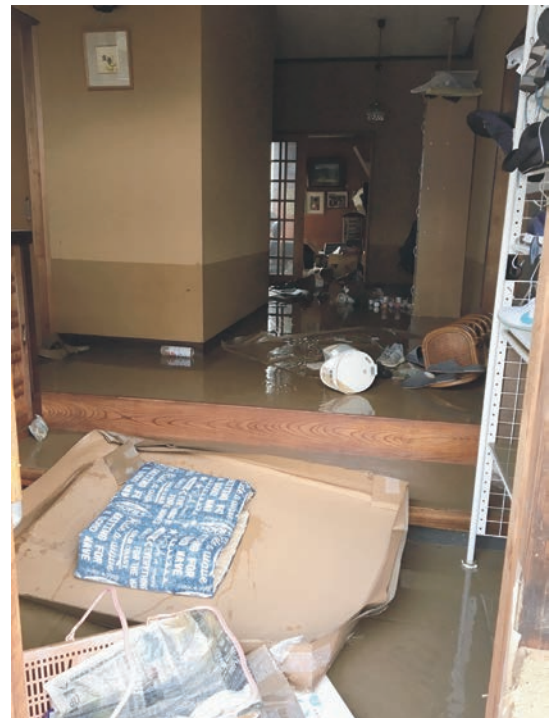
▼床上浸水し、泥まみれになった家屋
