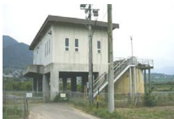
▲古牧東水源。千曲川の地下に潜流している伏流水を吸い上げています。
