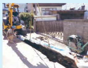
▲市道西町15号線の水道管路布設替工事。
