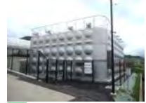
A 北部第1配水池
