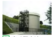
B 高丘配水池
