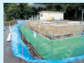
▲赤坂配水池の耐震補強工事。
