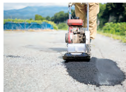
▲道路の穴を埋める修繕作業。穴一つひとつを埋める地道な作業です。
