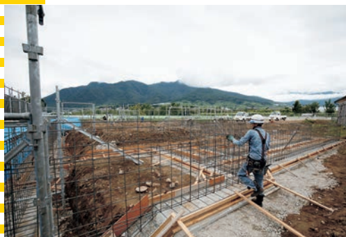
▲（仮称）新平岡保育園の基礎工事の様子
