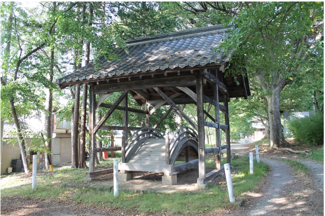
小内八幡神社輪橋
