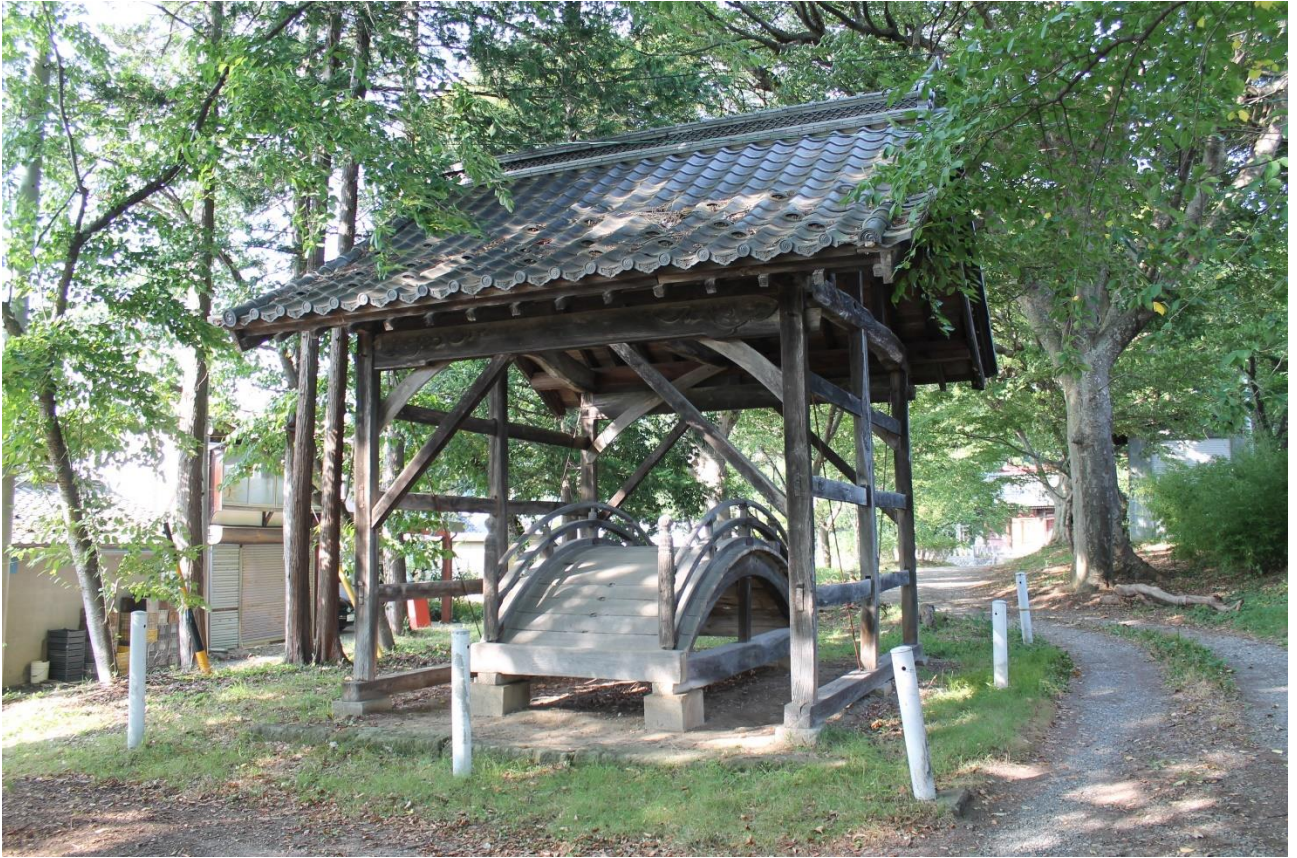
小内八幡神社輪橋
