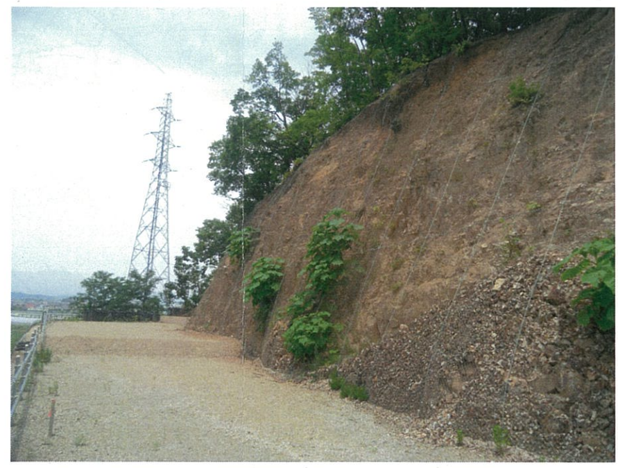
現状（未施工分の崖面）
