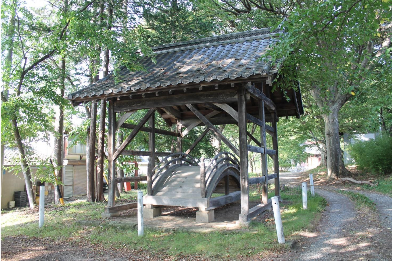
小内八幡神社輪橋
