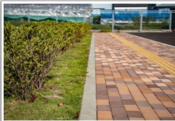
《インターロッキング歩道》
