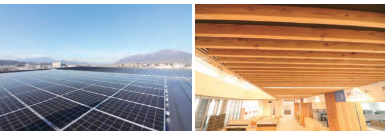
▲屋上に設置した太陽光発電パネル
