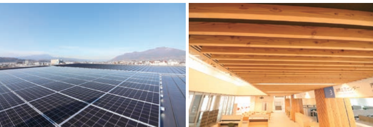
▲屋上に設置した太陽光発電パネル
