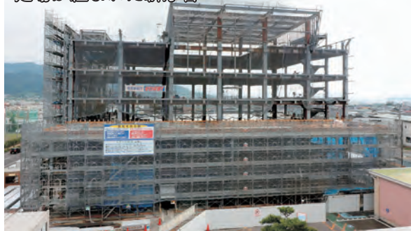
足場が組まれた新庁舎
