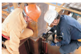
溶接箇所の超音波検査
