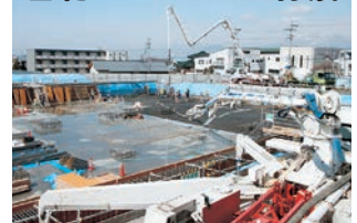
基礎コンクリート打設
