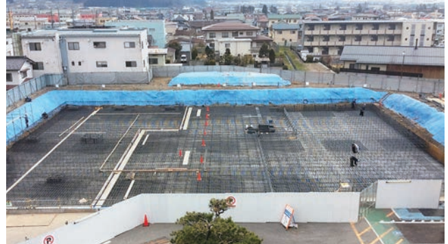
整然と配置された鉄筋
