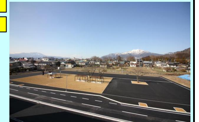
【地域生活基盤施設事業】 多目的防災広場整備
