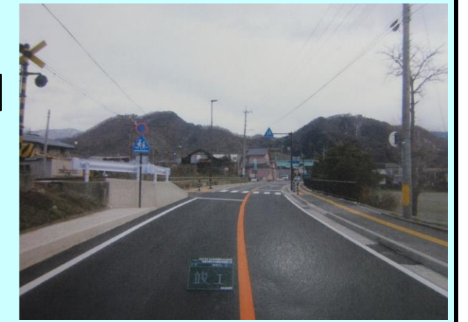
【道路事業】 市道中野26号線歩道整備
