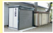
▲市の補助制度を活用して整備した西条区の防災倉庫
