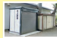
▲市の補助制度を活用して整備した西条区の防災倉庫
