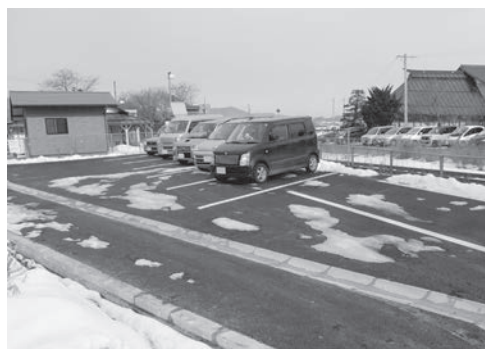
▲上今井駅南側に新たに整備した駐車場
