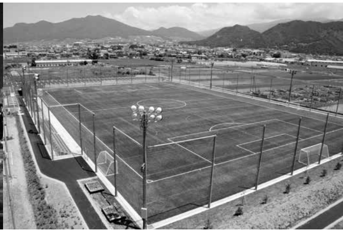
多目的サッカー場しゅん工 (6月30日)
