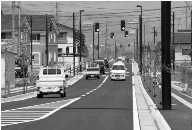
市道吉田西条線開通 (3月31日)
