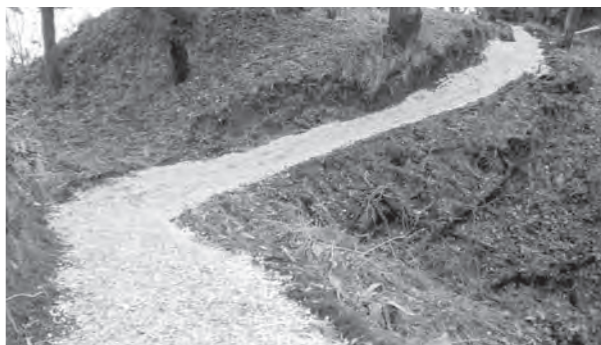
▲支給した木製チップを敷き詰めた遊歩道
