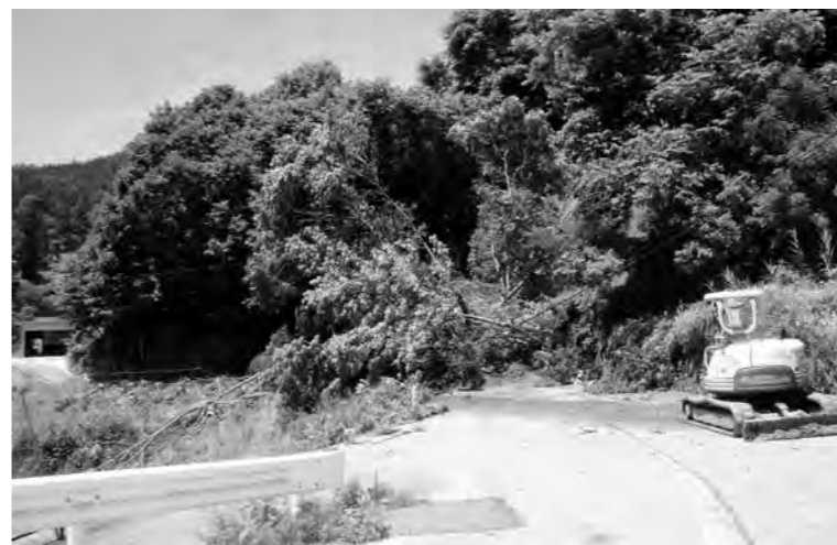
▲土砂と倒木で一時通行止めとなった道路(永田)
