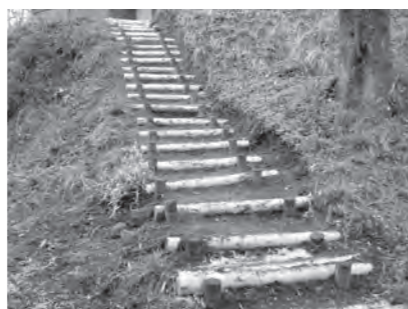
▲支給した丸太を使用した階段
