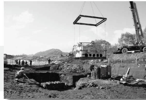
11月28日、ウレタン樹脂と鉄パイプで固めた青銅器埋納坑を搬出
