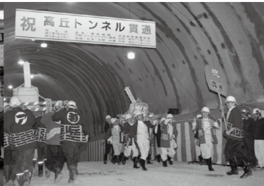
北陸新幹線高丘トンネル貫通式
