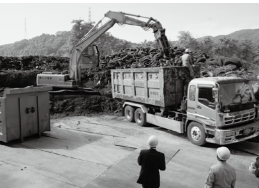
牛出地籍の放置廃タイヤ撤去作業開始
