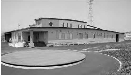
7月25日にしゅん工した南部学校給食センター
