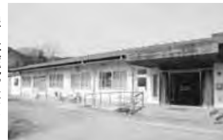
豊田社会就労センター 豊井分場の水洗化を行います
