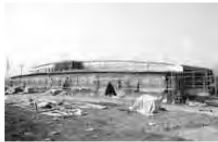
南部学校給食センターの完成に向けて建設工事を進めます
