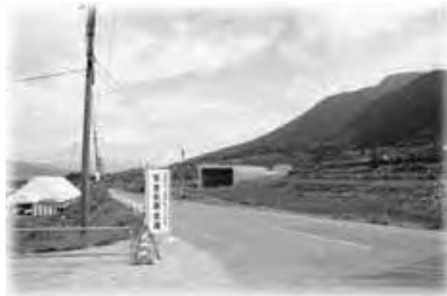
北陸新幹線の開通に向けて工事が進められます
