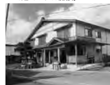
○南永江地区地域交流センター。昨年の秋に、区の間伐材を利用して建てられた施設。
