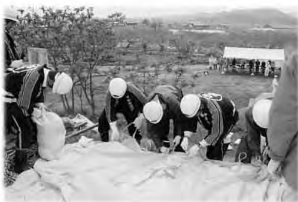
堤防を利用して「シート張り工」が行われました
